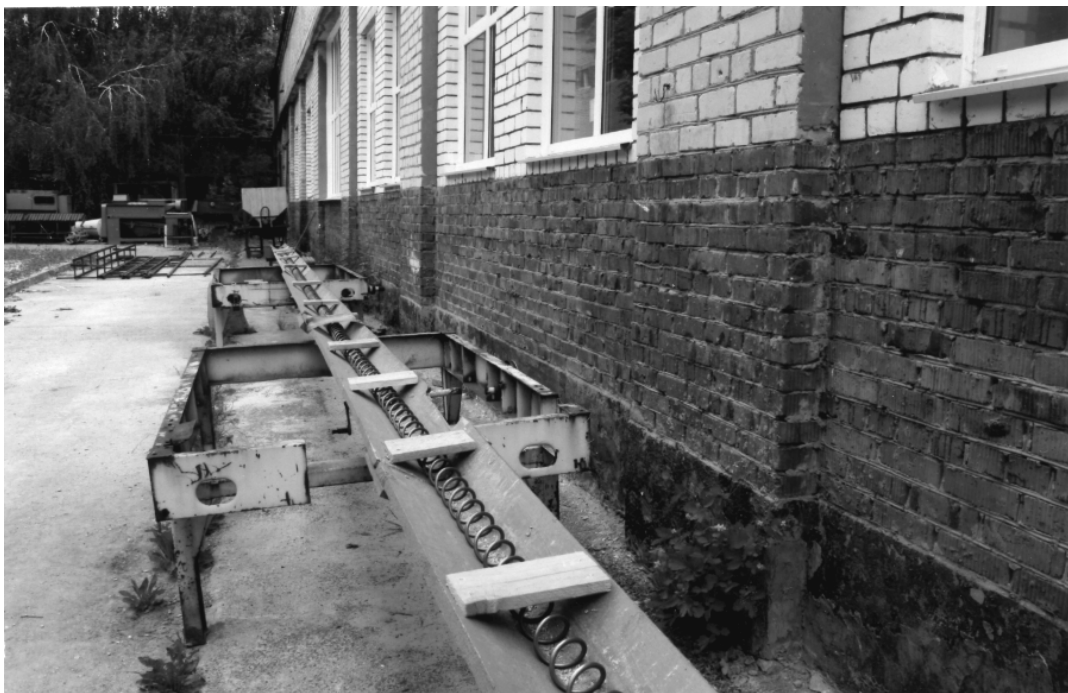
Рисунок 2.52 – Монтаж пружины на 50 м
