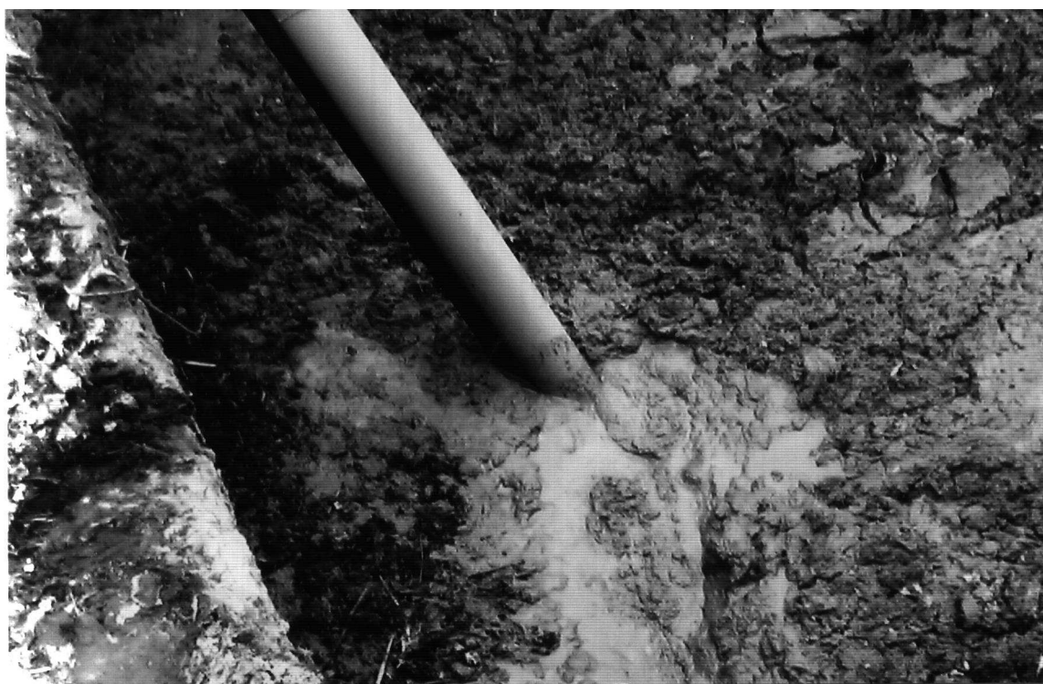
Рисунок 2.76 – Момент монтажа в колодце-накопителе насоса-транспортера (птицефабрика «Ульяновская»)
