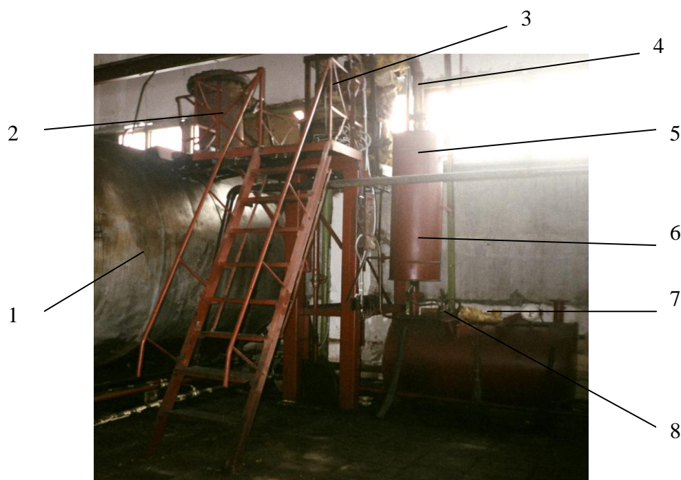
Рисунок 4.14 – Производственная установка очистки отработанных моторных минеральных масел
