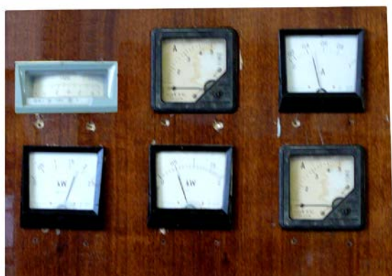
Рисунок 4.16 – Общий вид пускоизмерительной аппаратуры используемой для подключения насосов
