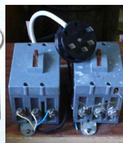
Рисунок 4.16 – Общий вид пускоизмерительной аппаратуры используемой для подключения насосов
