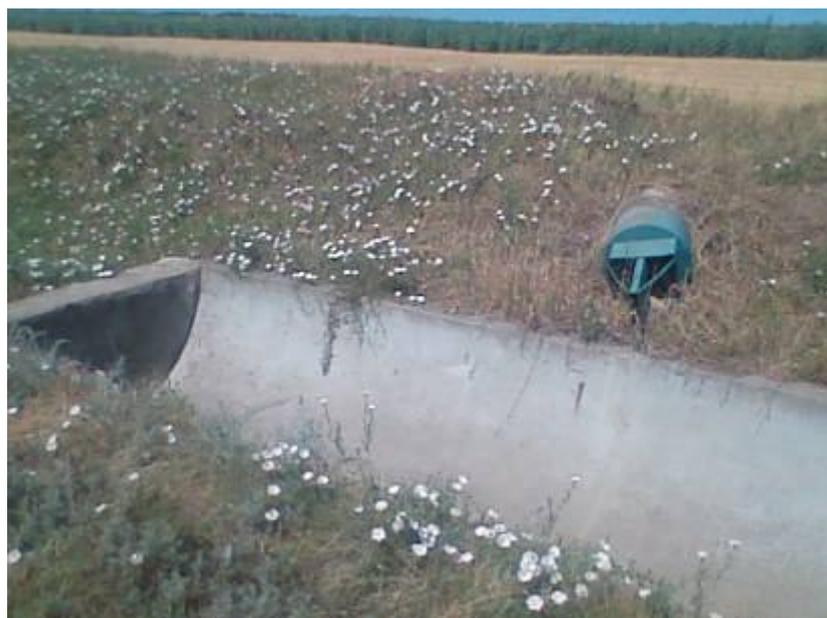
**Рисунок 10 – Водоприемный лоток стационарной стоковой площадки, п. Рассвет. Учеты объемов стока ведутся 39 лет**
