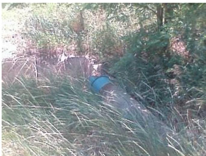
**Рисунок 13 – Водоприемник стационарной стоковой площадки
