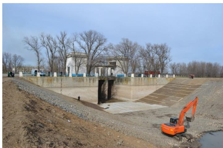
**Рисунок 50 – Реконструкция выходной части дюкера
