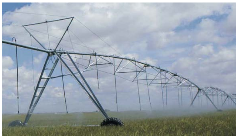
Рисунок 18.7 – Общий вид дождевальной части многоопорной широкозахватной (многопролётной) дождевальной машины кругового действия при поливе URAPIVOT
