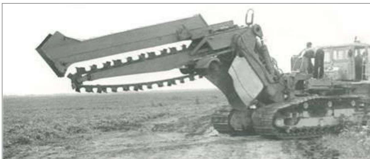
Рисунок 3.13 – Узкотраншейный дреноукладчик УДМ-350
