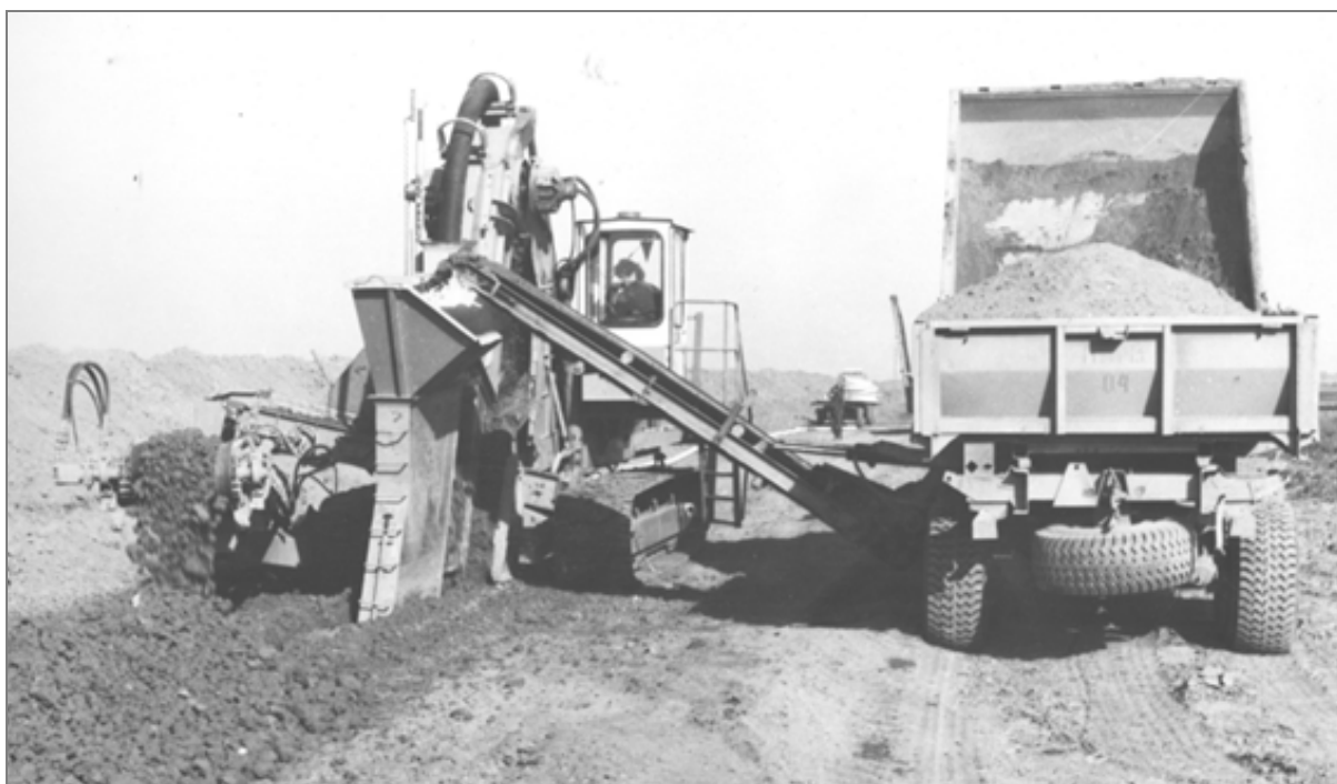
Рисунок 5.4 – Перегрузатель ПФП-13 в комплексе с дреноукладчиком 6027 «Хайконс»
