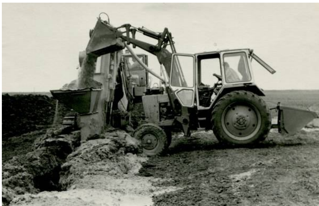
Рисунок 3.15 – Работа дреноукладчика УДМ-350 с погрузчиком ПФ-0,75 (ПКУ-0,8)
