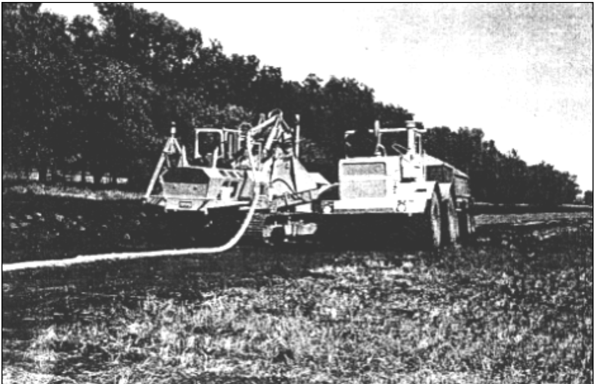
Рисунок 3.8 – Строительство узкотраншейного дренажа дреноукладчиком 6027 «Хайконс» в комплексе с перегружателем фильтроматериалов на базе ПРТ-16 (Ставропольский край, Изобильненский район, 1986 г.)
