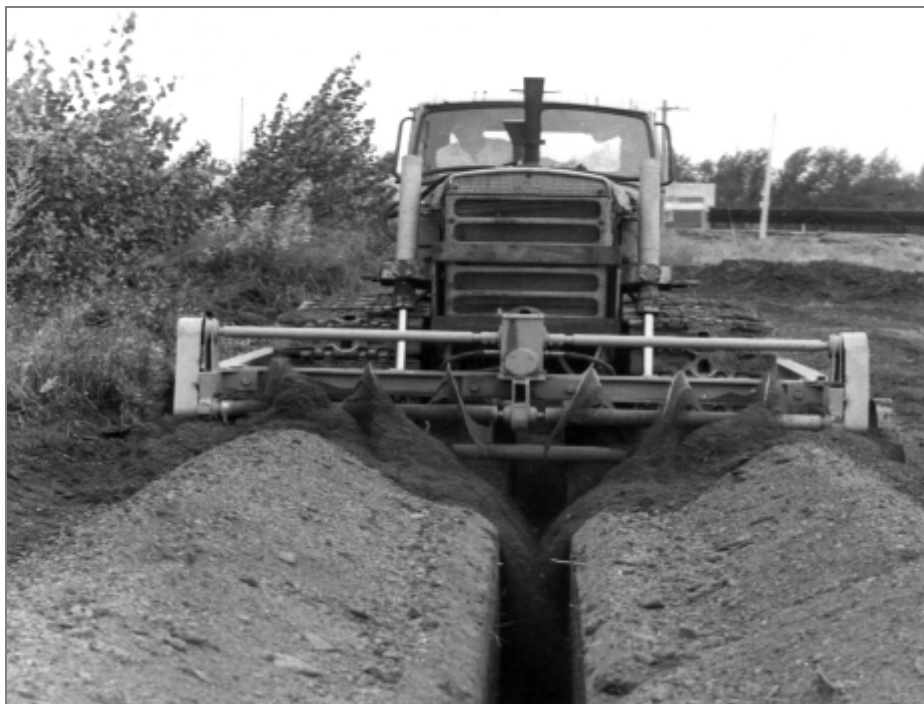
Рисунок 5.5 – Работа экспериментальной машины обратной засыпки (МОЗ-2) дренажных траншей после прохода узкотраншейного дренаукладчика
