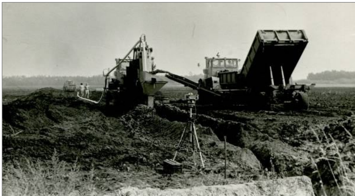
Рисунок 3.14 – Работа дреноукладчика УДМ-350 с перегружателем фильтроматериалов ПФП-13 по лазеру УКЛ-1
