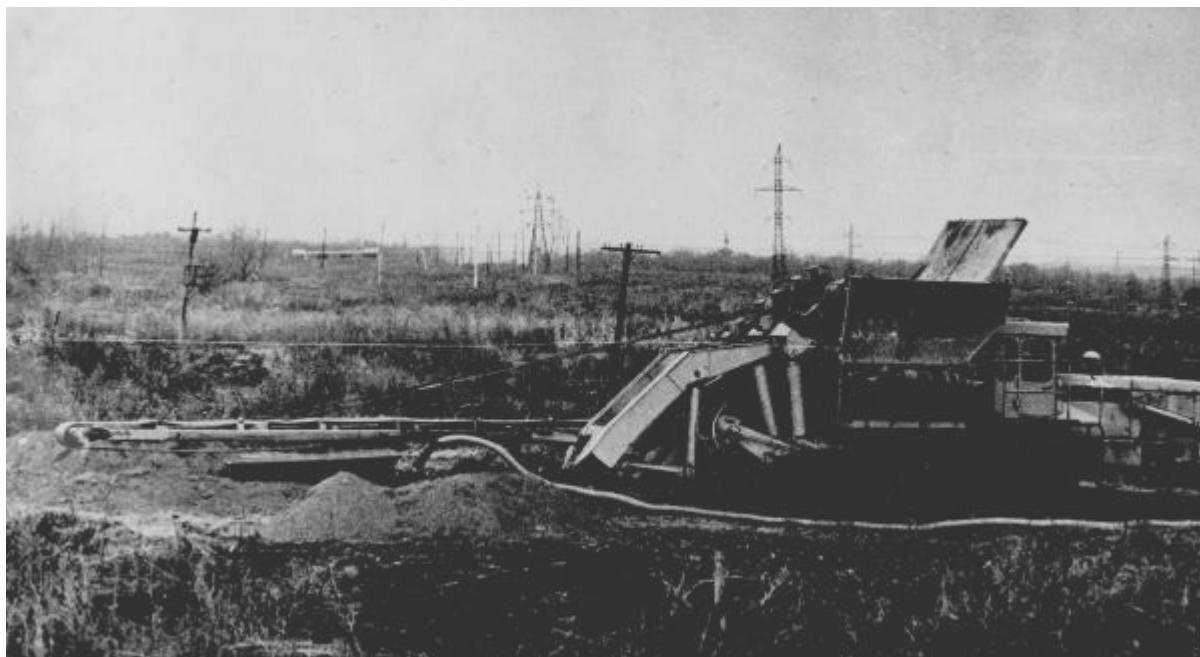
Рисунок 3.12 – Строительство дренажа экскаватором-дреноукладчиком ЭТЦ-406А в грунтах естественной влажности
