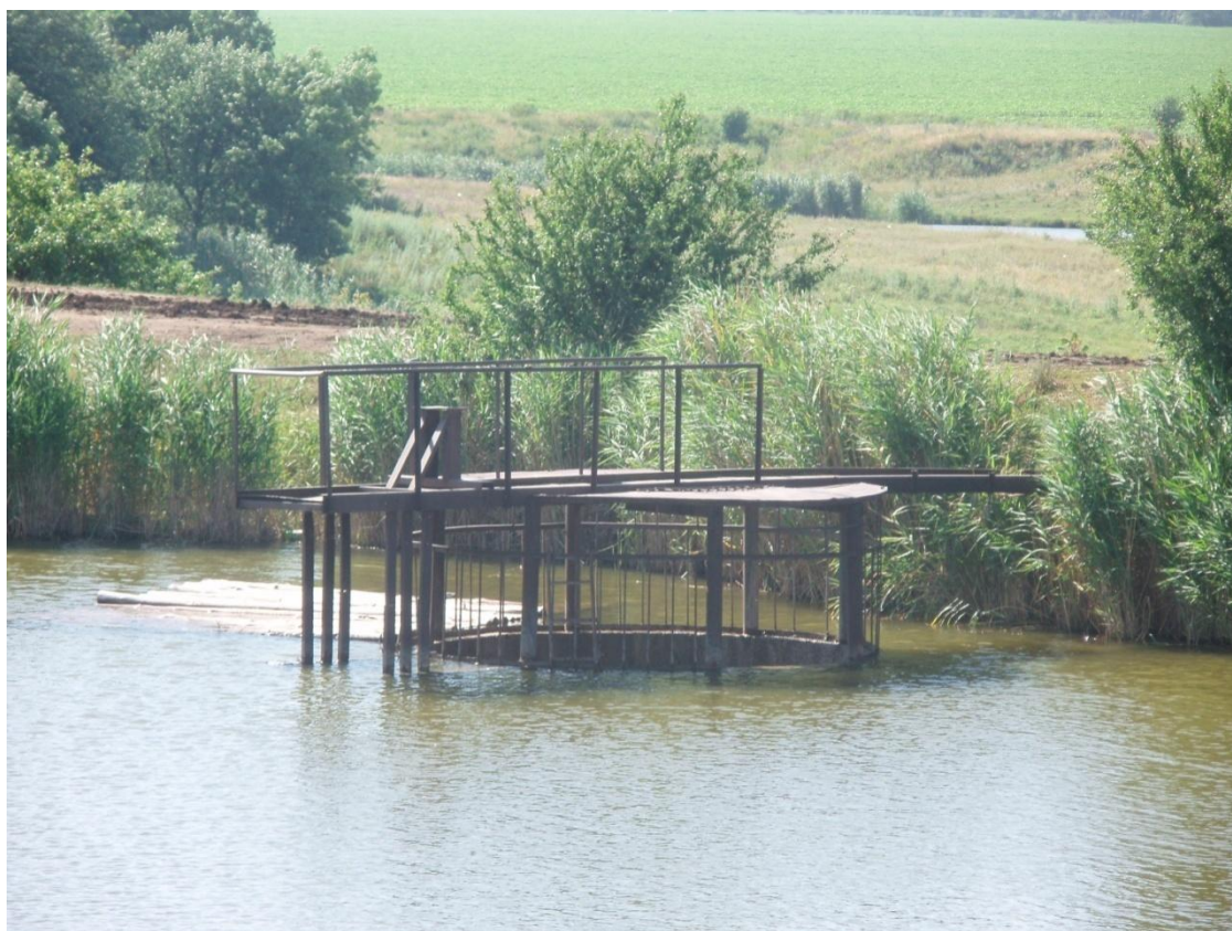
Рисунок 12.10 – Входная часть шахтного водосброса
