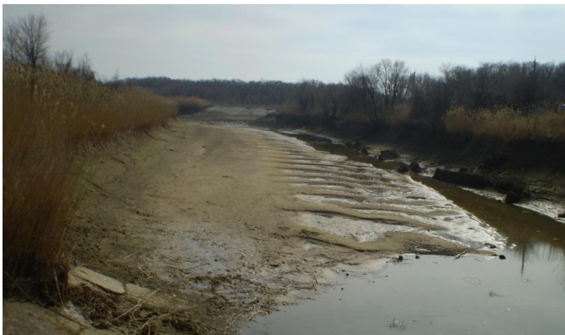
Рисунок 10.9 – Оплывы дамб Донского магистрального канала
