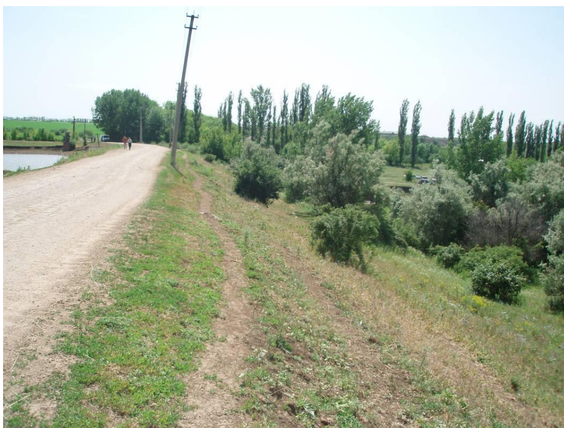
Рисунок 12.19 – Сухой откос плотины (вид с правого крыла плотины)
