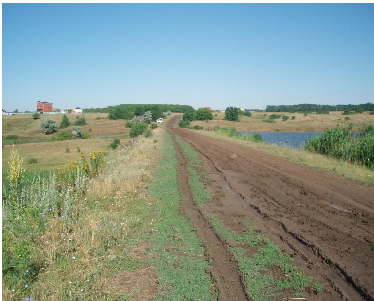
Рисунок 12.8 – Фрагмент гребня плотины (проезжая часть)
