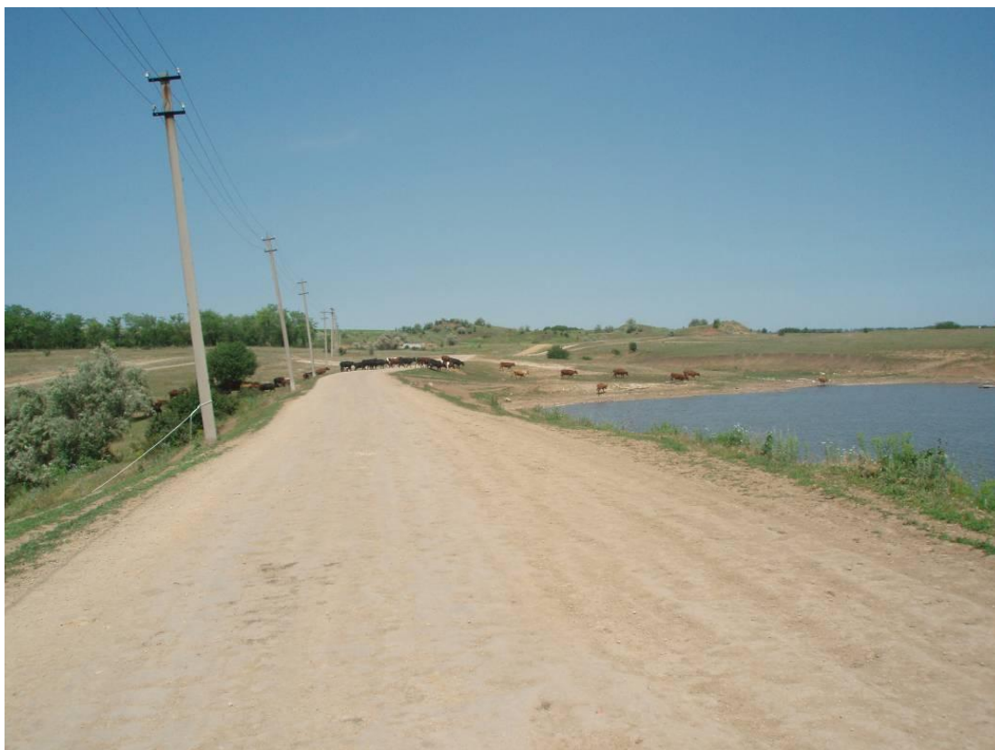
Рисунок 12.18 – Фрагмент гребня плотины (проезжая часть)
