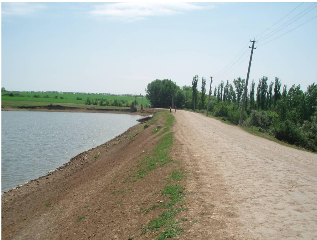
Рисунок 12.20 – Фрагмент гребня и мокрого откоса плотины
