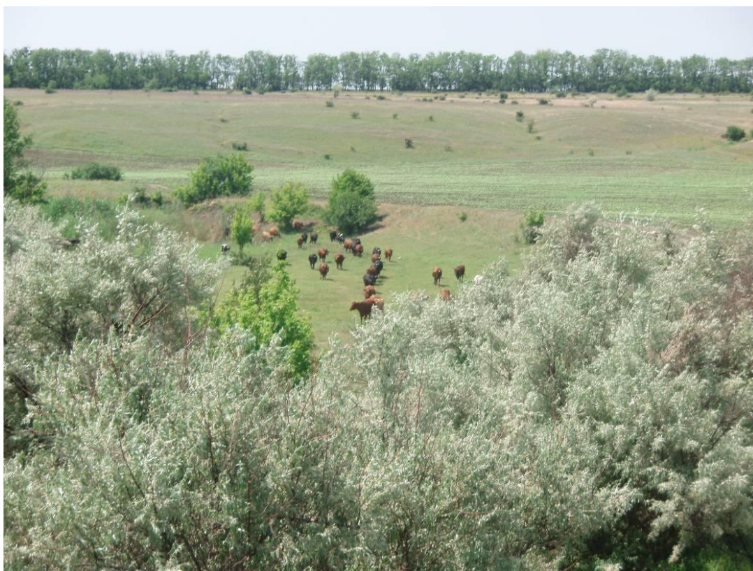
Рисунок 12.25 – Вид нижнего бьефа с гребня плотины
