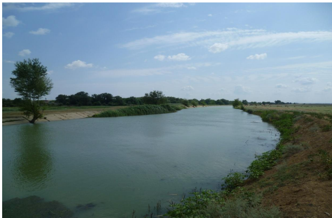
Рисунок 10.5 – Общий вид Пролетарского магистрального канала
