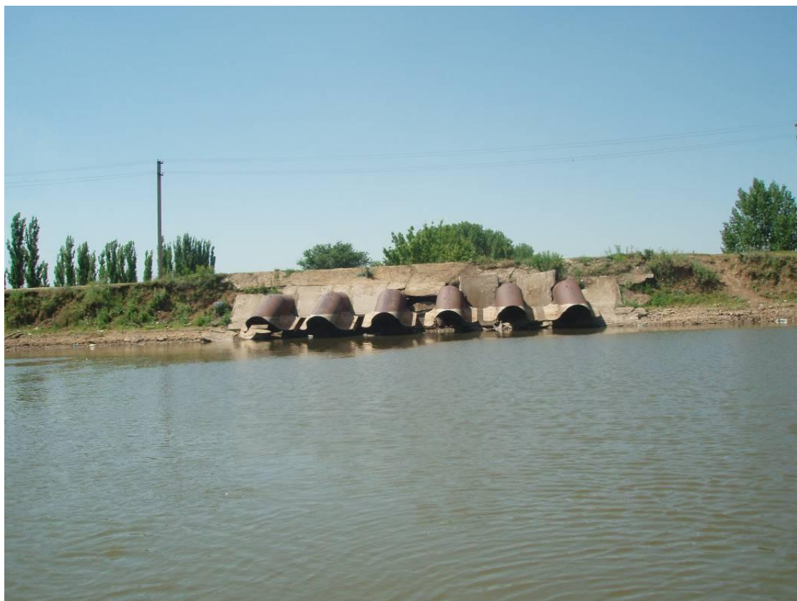
Рисунок 12.22 – Входная часть сифонного водосброса
