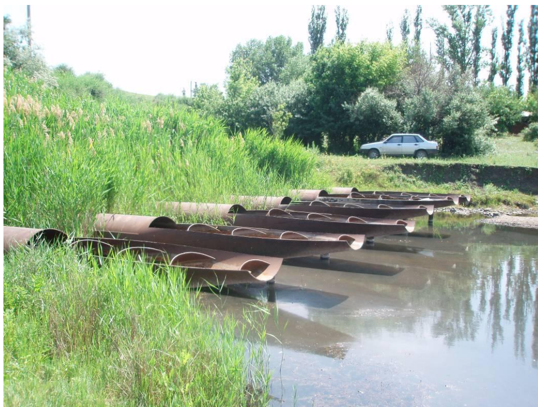
Рисунок 12.23 – Выходная часть сифонного водосброса и яма размыва
