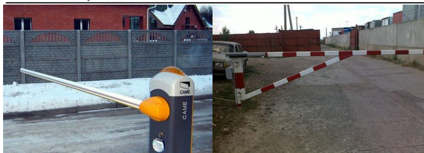
Рисунок 1 – Виды шлагбаумов а) подъёмные; б) поворотные
