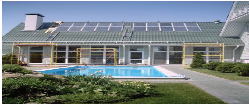
Рисунок - Общий вид солнечной батареи
